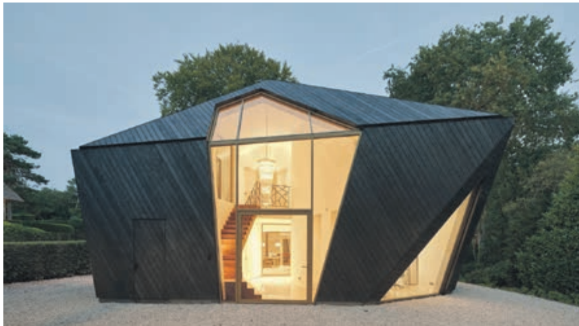
Het Diamond House in Loosdrecht is één van de kanshebbers in de categorie 'Particuliere houtbouw'.
