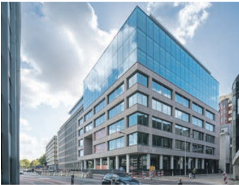
The Cath is een historisch gebouw, volledig herontwikkeld tot het eigentijds en duurzaam kantoor.
