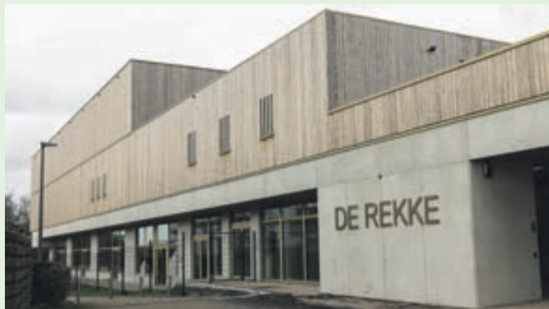
Het Kebony hout, dat na verloop van tijd natuurlijk vergrijs, biedt een warm contrast met het grijze beton.
