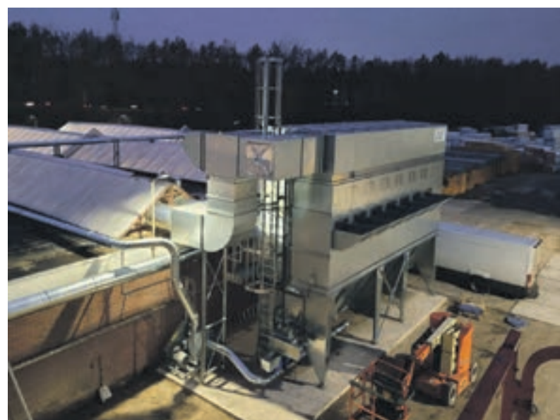
Een goede luchtzuiveringsinstallatie omvat gemiddeld zo’n 20 procent van het totale machinebudget.
